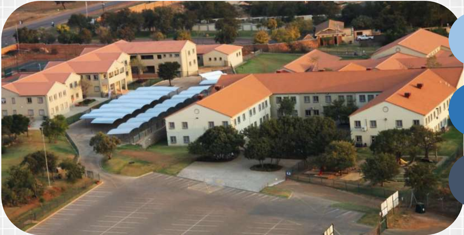
Curro Roodeplaat (2010) (Castle & Grades R – 12)
